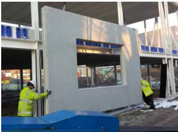
Inbouw prefab betonnen sandwichwand uitgevoerd met Schöck Thermoanker
