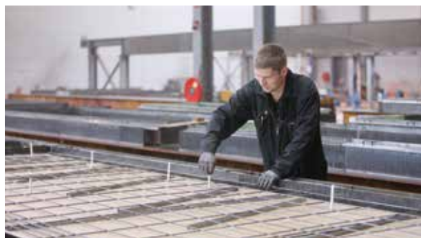
Stap 4: Insteken van de Thermoanker staven in de voorgeboorde gaten en in de verse betonschil.
