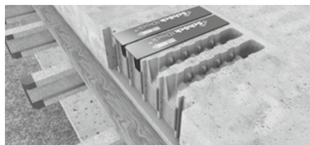
Schöck IDock® sparingselementen verwijderen
