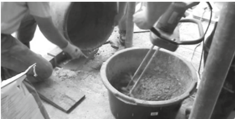
Cuglaton® mortel met handmenger bereiden
