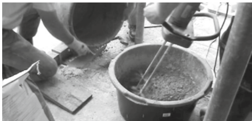
Cuglaton® mortel met handmenger bereiden
