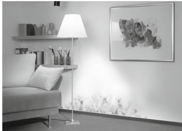
Afb. 6: Voorbeeld van bouwschade door schimmelvorming
